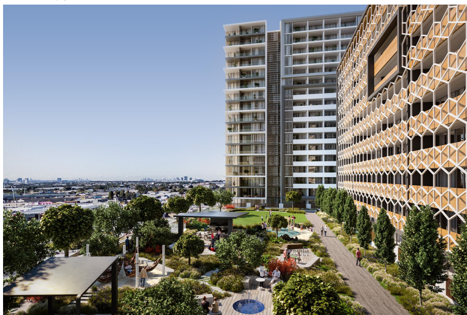
图三 首开澳宝公司格兰威尔住宅项目
